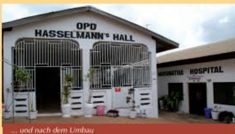
... und nach dem Umbau
