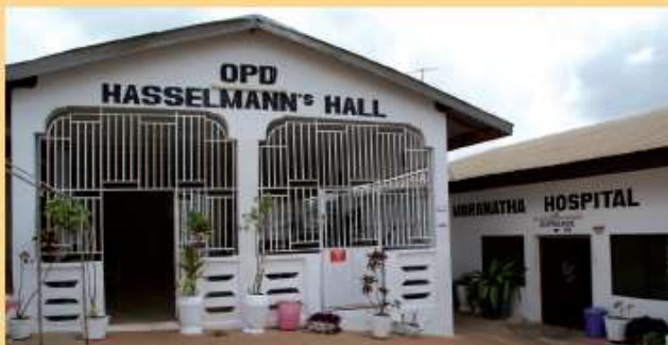
... und nach dem Umbau
